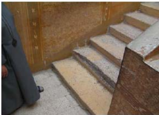
Das zu sanierende Treppenhaus
